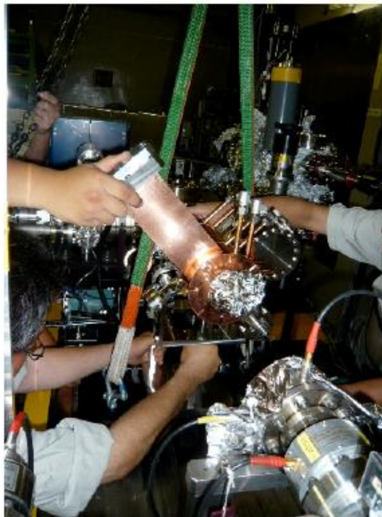
ATF インストールの様子
