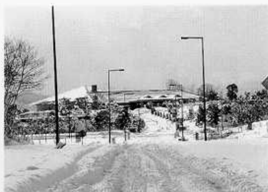
雪化粧した新都市 ゴルフ場の入口付近
